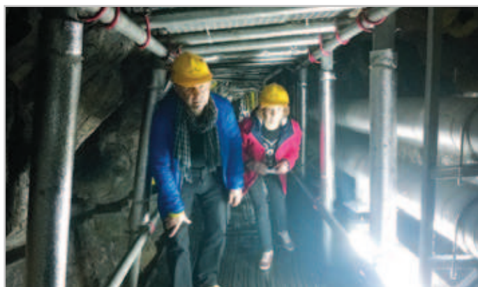
Trzeci tunel odkryty w latach 30-tych.
