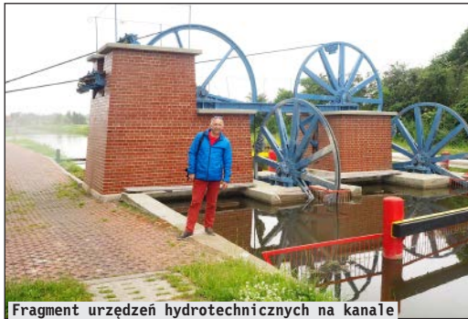
Fragment urządzeń hydrotechnicznych na kanale
